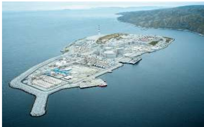
Statoil LNG, Hammerfest
