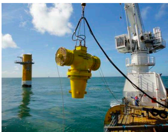
Joonis 3-9. Kaevamistehnikad hüdraulilise veealuse varustusega; T-seeria ekskavaator vasakul, savilõikur paremal (Ramboll 2014a).
