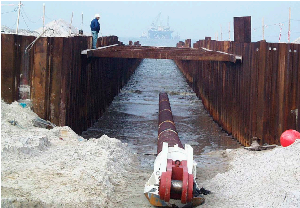
Joonis 3-15. Tõmbepea väljumine merest toru kaldale tõmbamisel (Ramboll 2014a).
