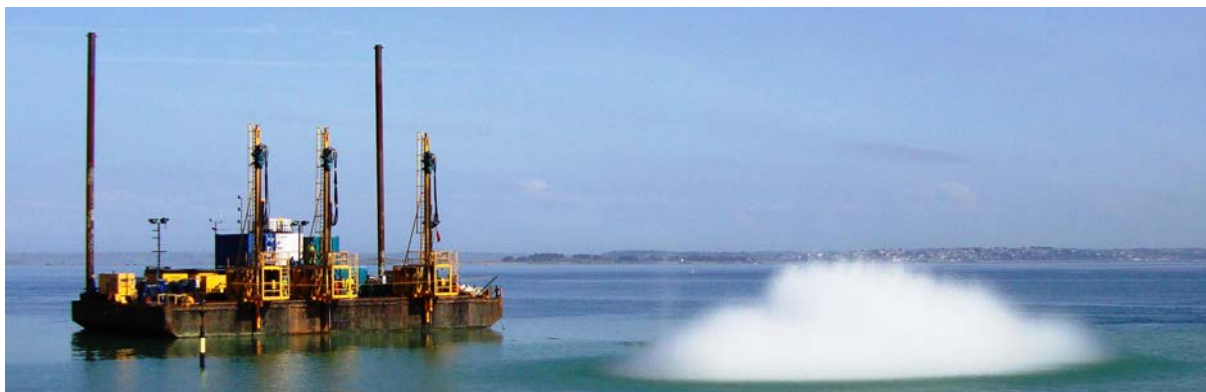
Joonis 3-10. Kontrollitud veealune kaljupinnase lõhkamine (Ramboll 2013).
