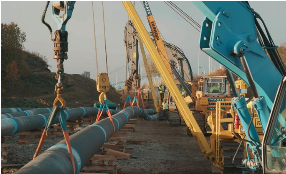
Joonis 4.13 Meretoru paigaldamine Paldiski FSRU ühendamiseks
