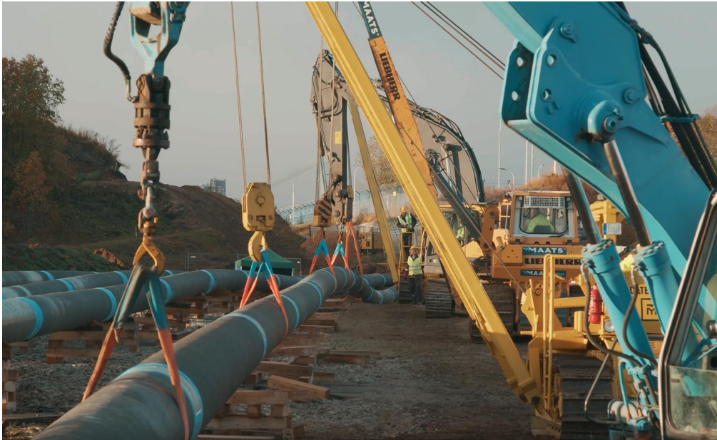
Joonis 4.13 Meretoru paigaldamine
