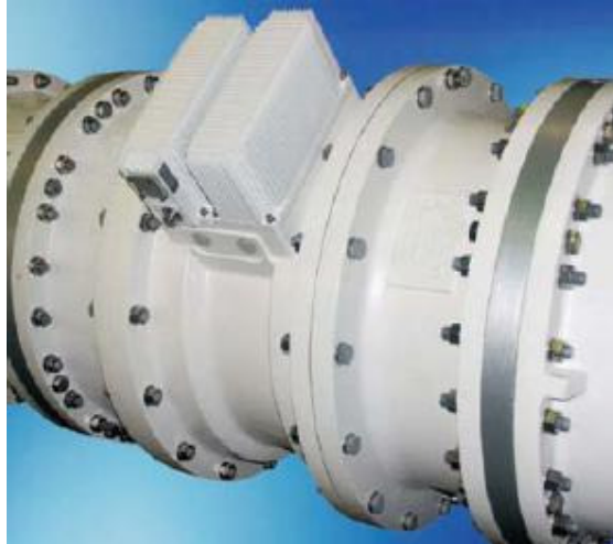
Joonis 4.11. Laufenbergi alajaamas rakendatud ABB ELK-CP3 kombineeritud pinge- ja voolutajuri lähivaade.
