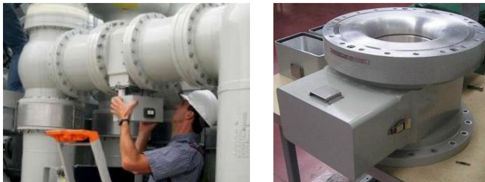
Joonis 4.3. Saumade alajaamas olevad kombineeritud gaasalajaama mõõtemuundurid lähivaates. Allikas: http://www.scribd.com/doc/37662127/1 ; [40].
