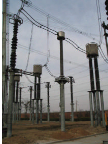
Joonis 4.16. Firma Schniewindt mittetavapärased voolumõõtemuundurid Hiinas Zhengzhou alajaamas.
