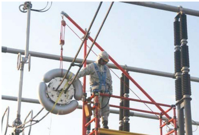
Joonis 4.9. Rogowski voolutajuri paigaldamine Rondissone alajaamas.
