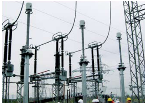
Joonis 4.4. La Prairie alajaama paigaldatud optilised voolutrafad [41] (ilmselt enne paigalduse lõppu, näha on nendega mitteühendatud juhid).
