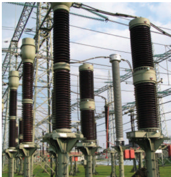
Joonis 4.12. Firma Schniewindt poolt toodetud HECT/VT kombineeritud mõõtemuundur (pildil paremalt teine) Saksamaal RWE Wesel'i alajaamas.
